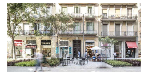
Reurbanització carrer Comte Borrell - Barcelona
