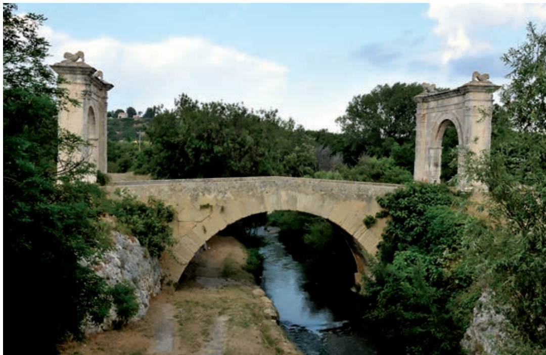
Pont Flavien de Saint-Chamas (Boques del Roine), sobre el riu Touloubre, construït al s. I aC en la ruta entre Marsella i Arles. Font: Wikimedia Commons. Tanis 13.
