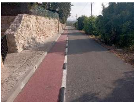
Mostra 3 - Estat actual del camí de l'Oliverot a l'arribada a l'àmbit. Fotografia pròpia.
