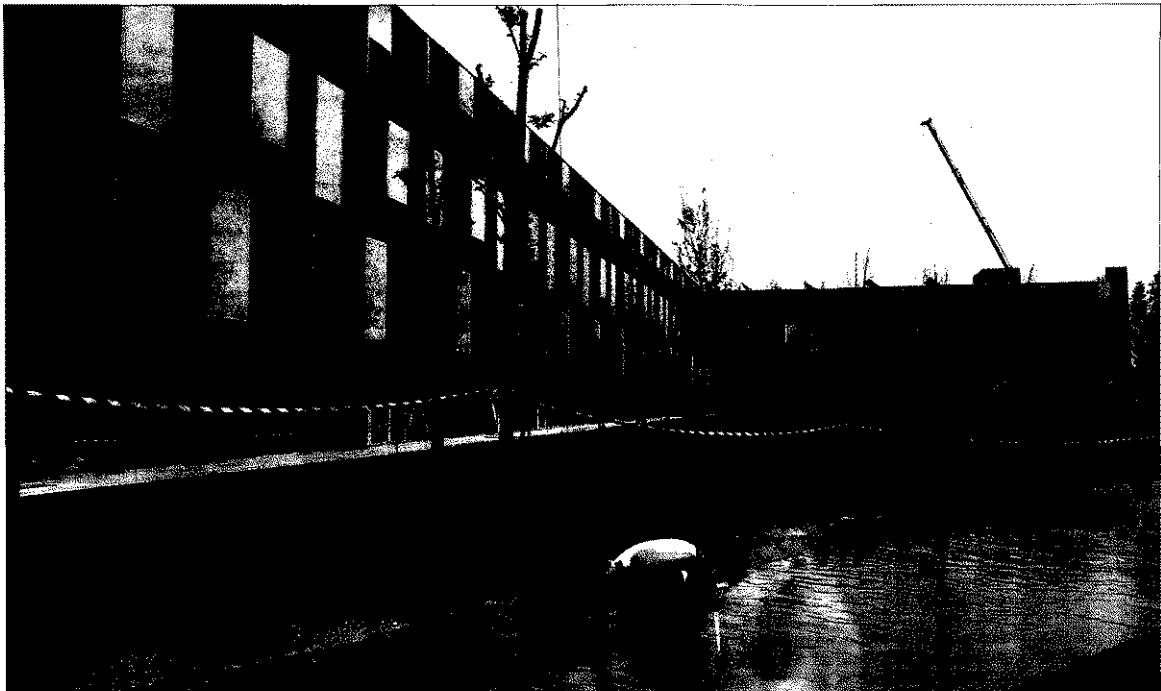
►► Un operari treballa, ahir, al canal construït a la part posterior del nou centre del Prat.
