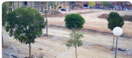
Inicio de las obras en la Plaza de la Amistad
