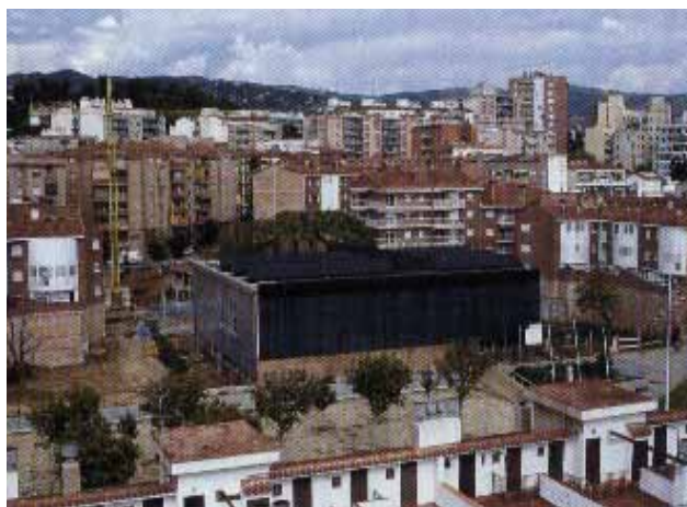
La biblioteca Pompeu Fabra de Mataró incorpora mòduls fotovoltaïcs multifuncionals integrats que produeixen energia elèctrica i tèrmica.
