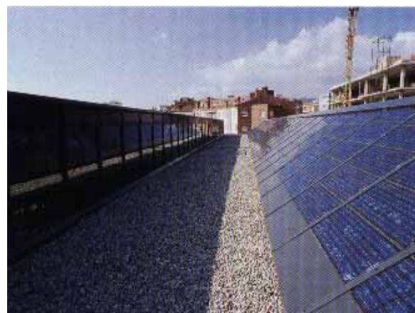
Al terrat de l'edifici, hi ha quatre files de lluernes fotovoltaïques construïdes amb mòduls fotovoltaics opacs i semitransparents.
